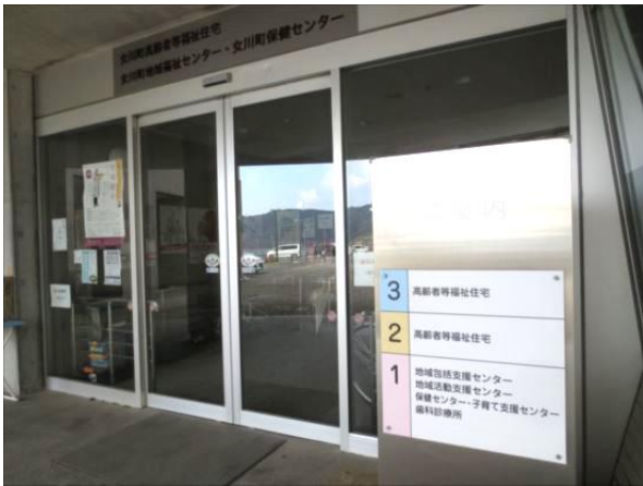
37 地域福祉センター1階に保健センター等の施設がまとまり、2・3階は高齢者福祉住宅。
