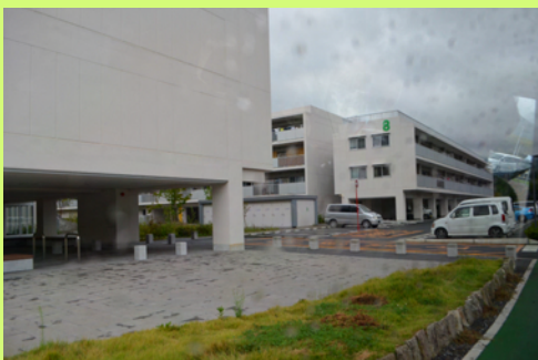
女川町営運動公園に建設された災害復興公営住宅
