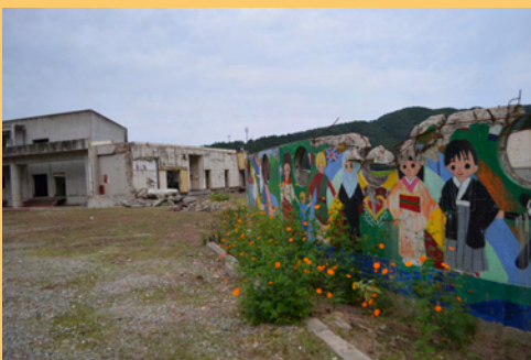
コンクリートの壁面も崩壊してました
